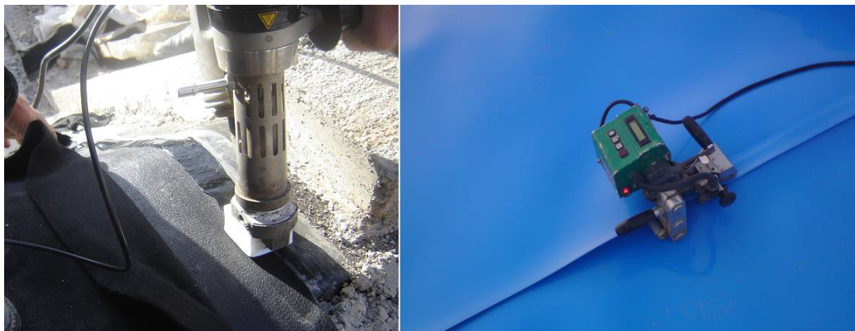
تصویر ۷: دستگاه جوش دو خطی گوه داغ و دستگاه اکسترودر حین کار
