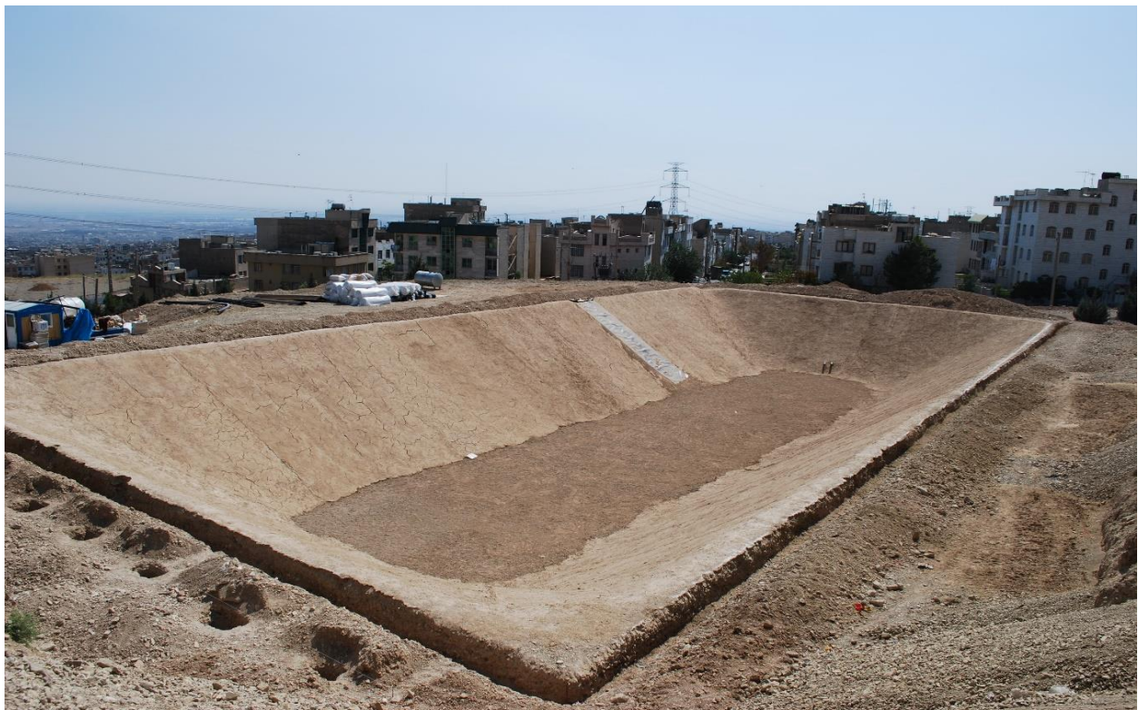
تصویر ۳: نمونه بستر آماده شده و مناسب برای اجرای لایه ژئوممبرین
