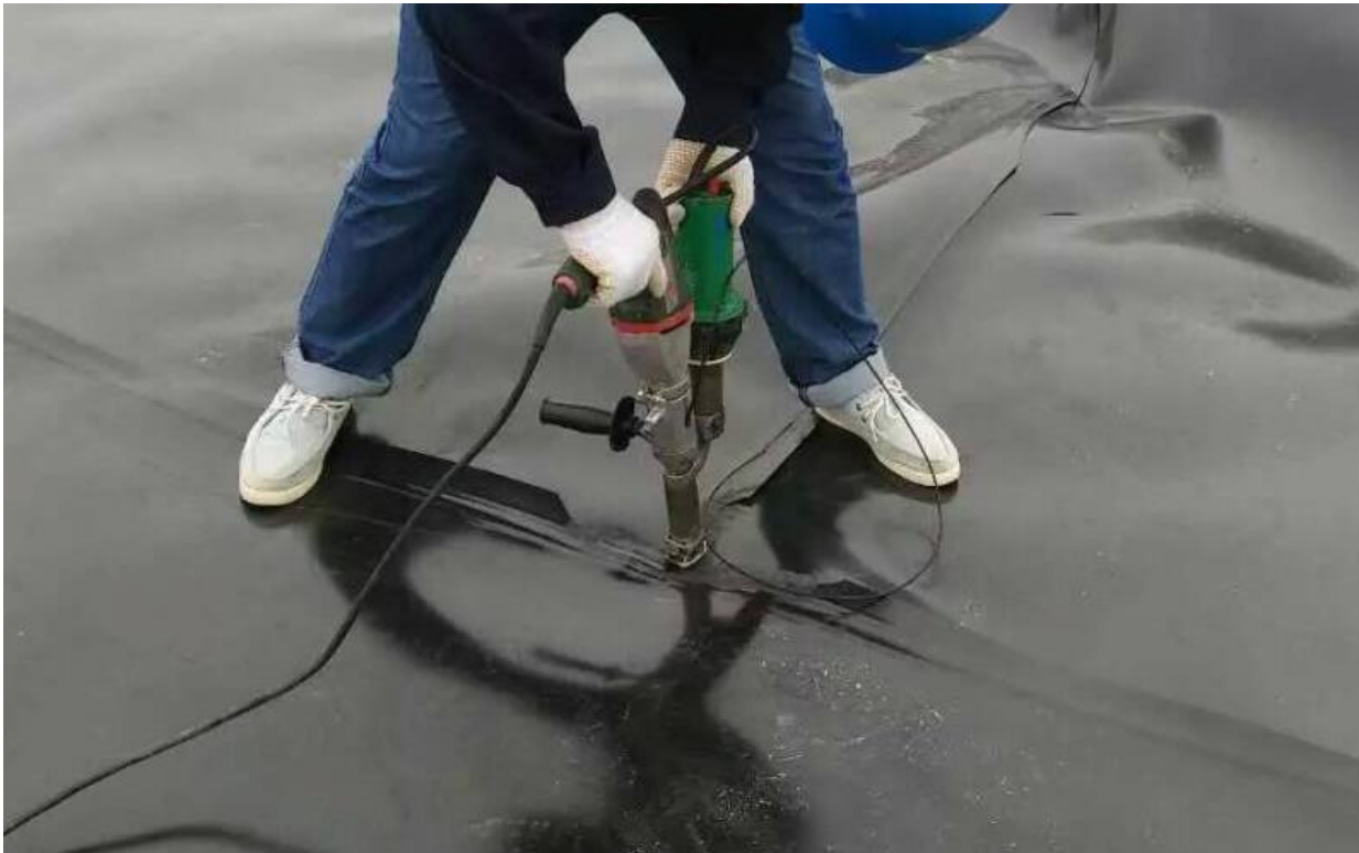
تصویر ۹: انجام عملیات جوشکاری و آب بندی T-Joint
