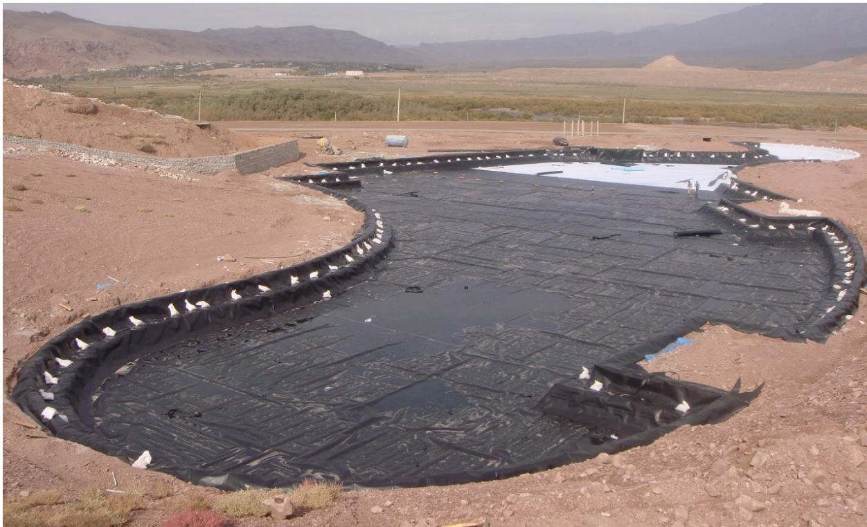
تصویر ۵: مهار پوشش ها با استفاده از کیسه شن
